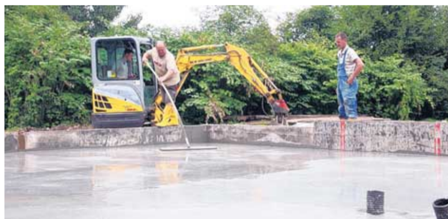
Jürgen Schaller gibt dem frischen Beton der Bodenplatte des neuen Gästehauses den letzten Schliff. Jetzt kann der Rohbau in die Höhe wachsen. Foto: Ralf Saupe
